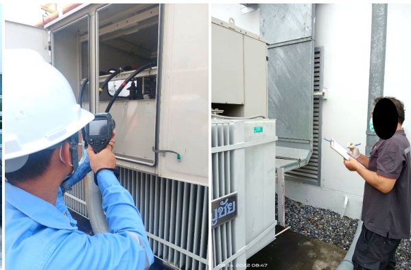
รูปที่ 2-26 การตรวจสอบหม้อแปลง ขนาด 2,000 KVA ของโครงการ
