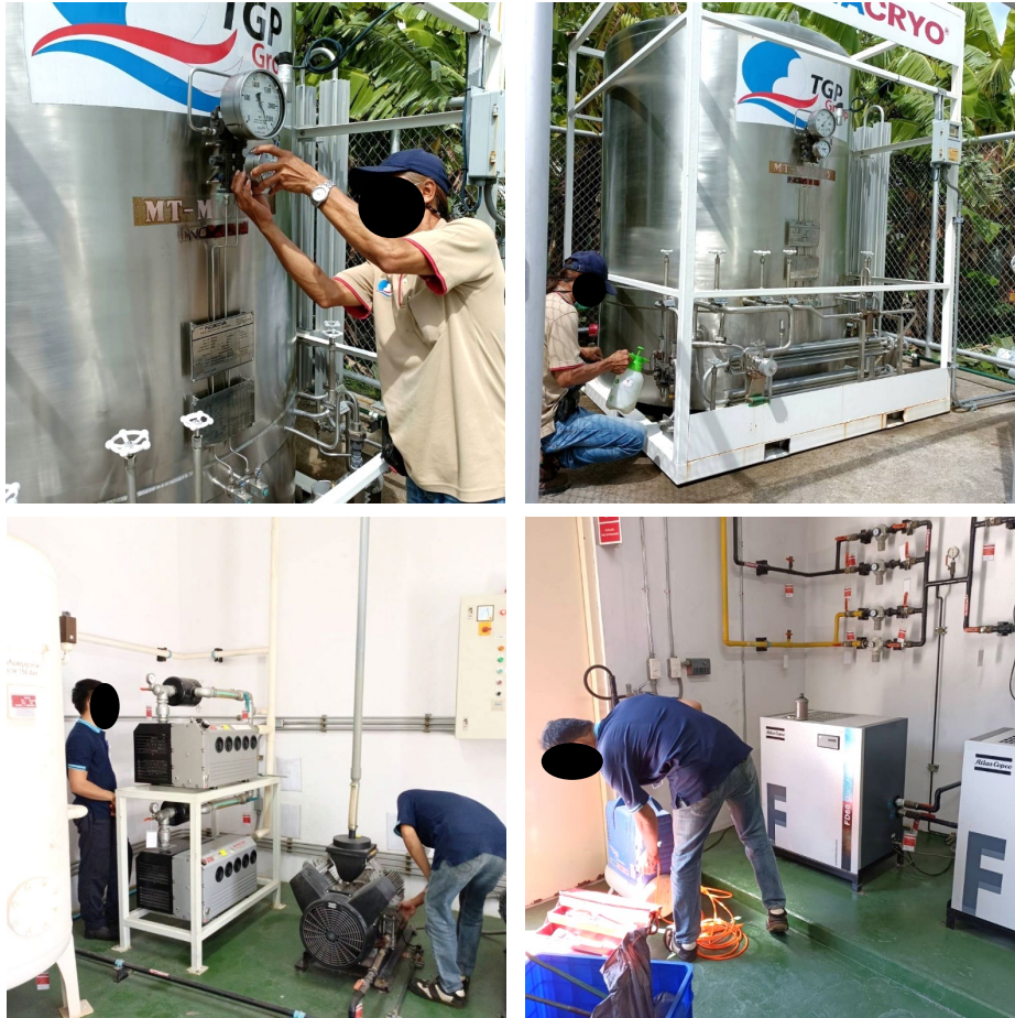
รูปที่ 2-40 การตรวจสอบดูแลระบบออกซิเจนเหลว 1 ครั้ง/ปี และระบบแก๊สทางการแพทย์
