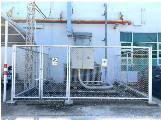
รูปที่ 2-26 การตรวจสอบหม้อแปลง ขนาด 2,000 KVA ของโครงการ
