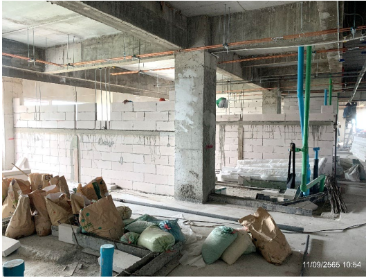
รูปที่ 2-4 การก่อสร้างผนังกันห้อง ชั้นที่ 8
