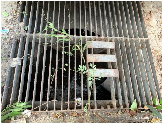
รูปที่ 2-13 ตะแกรงดักตะกอนที่ระบายน้ำ
