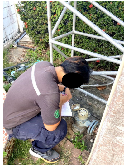
รูปที่ 2-31 การตรวจเช็คมิเตอร์น้ำและจดบันทึกปริมาณการใช้น้ำเป็นประจำ
