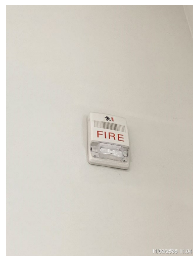
อุปกรณ์ส่งสัญญาณเสียง Strobes and Horns
