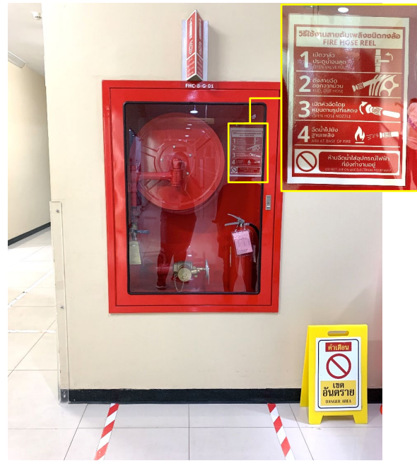
ถังดับเพลิง และตู้เก็บสายฉีดน้ำดับเพลิง พร้อมวิธีการใช้งาน
